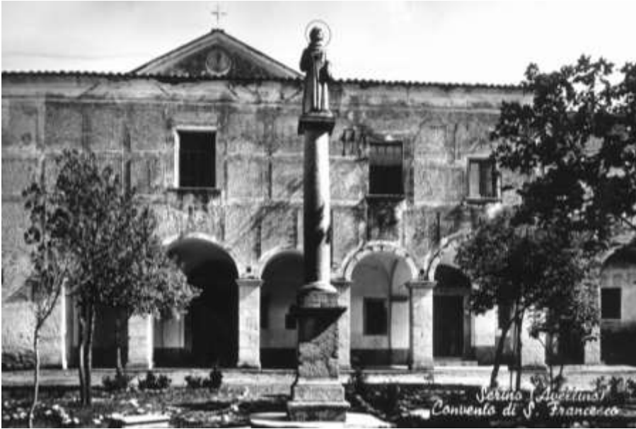
Serino. Convento di S. Francesco. Prospetto ed ingresso alla Chiesa
